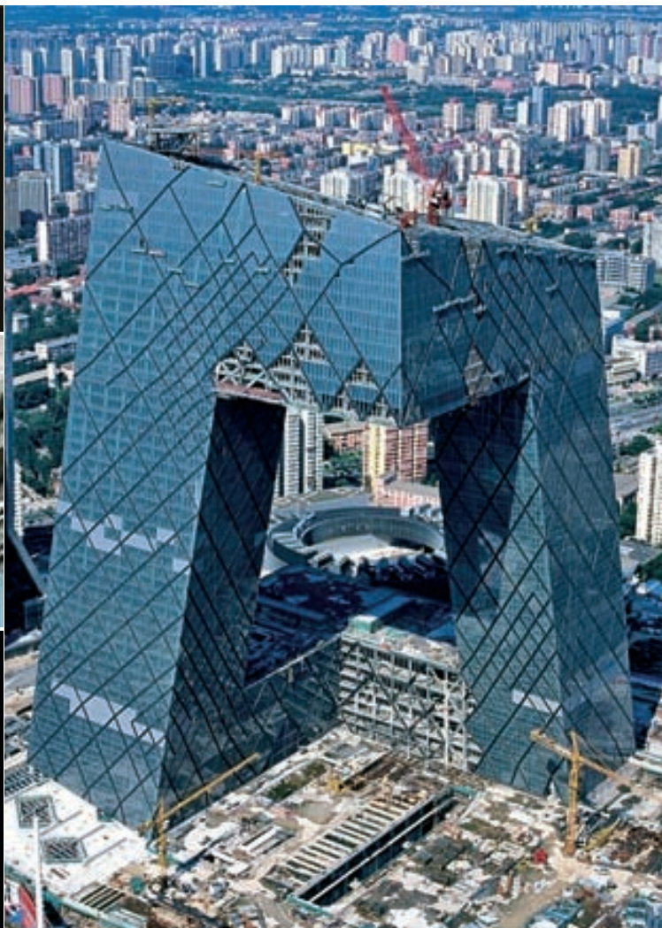
幕墙结构施工
