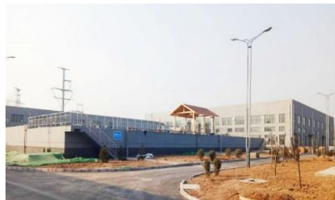
河北邢台污水处理二厂项目
