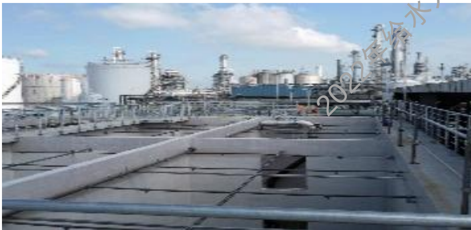
新加坡裕廊岛石化污水处理项目
