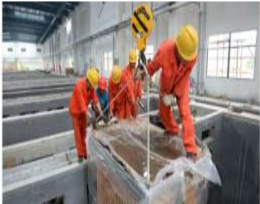
福州洋里污水厂 提标改造工程
