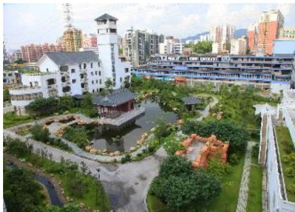
广州京溪地下净水厂
