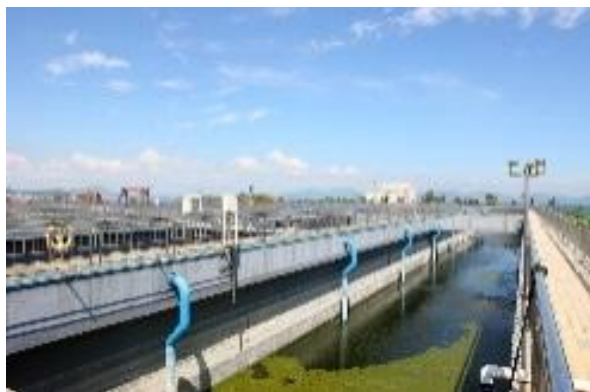
广州南沙小虎岛污水厂
