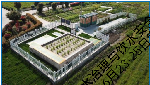
兰亭街道黄贤终端： A 2 O + 生物滤池工艺
