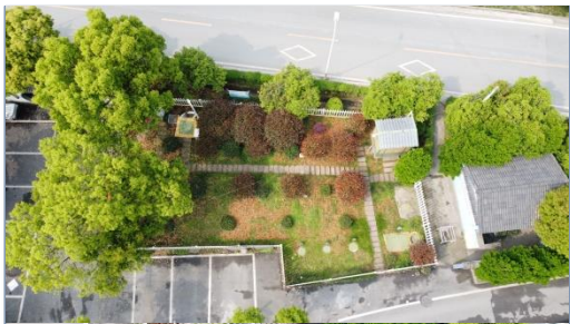
柯岩街道河塔2#终端： 高负荷地下渗滤工艺
