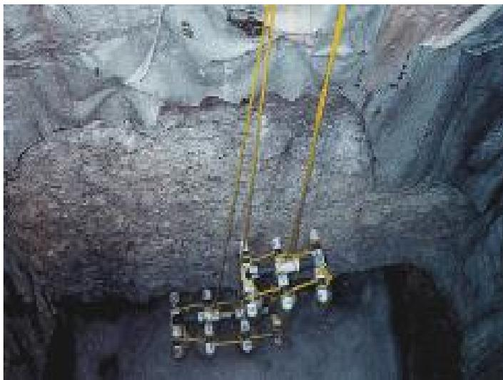
有机涂料由于基面混凝土内渗水而出现起鼓、剥落等现象
